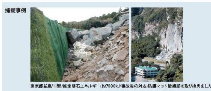
**Q7. ジオロックウォールは、落石の作用に対して落石防護施設としての要求性能を満足しますか？**
